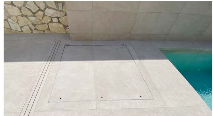
Tapa con el marco encofrado y la bandeja rellena con gres porcelánico. Fabricación a medida, proyectos personalizados
