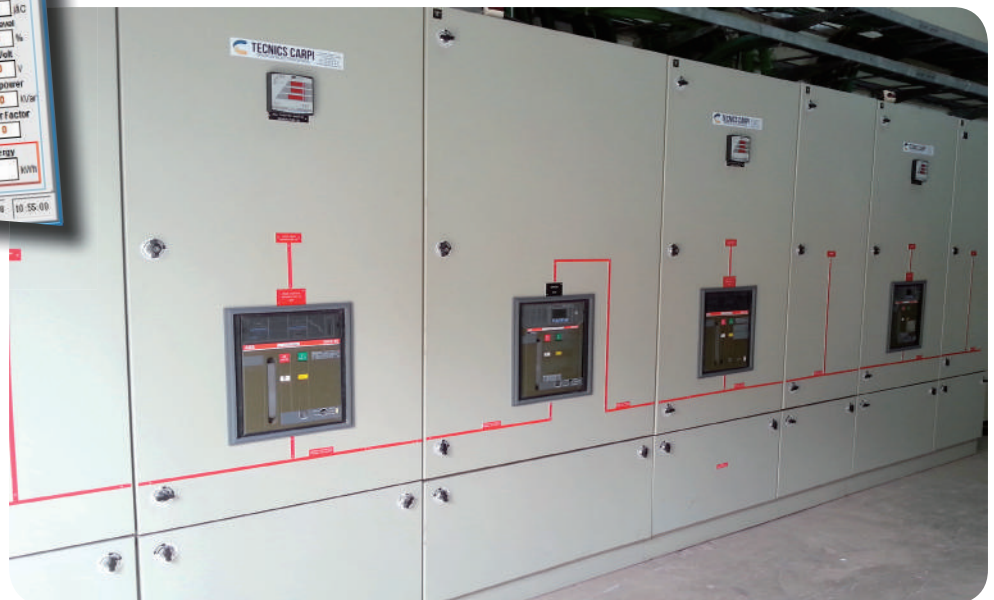
Cuadros de conjunto de grupos electrógenos sincronizados y controlados remotamente - Hospital La Paz - Bata (Guinea Ecuatorial)
