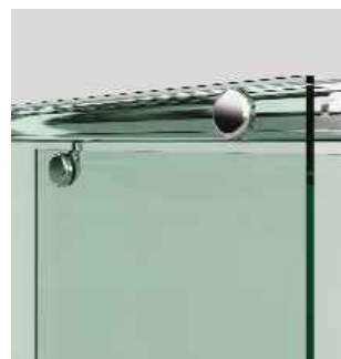
Fijación vidrio-perfil
