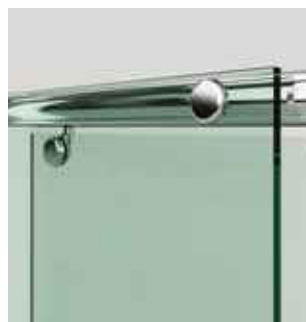
Fijación vidrio-perfil
