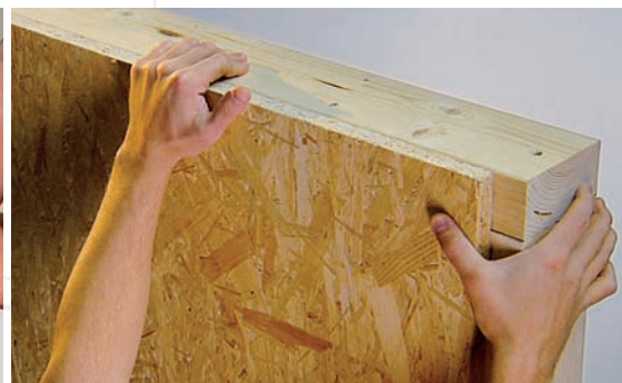
Realización de estructuras en madera
