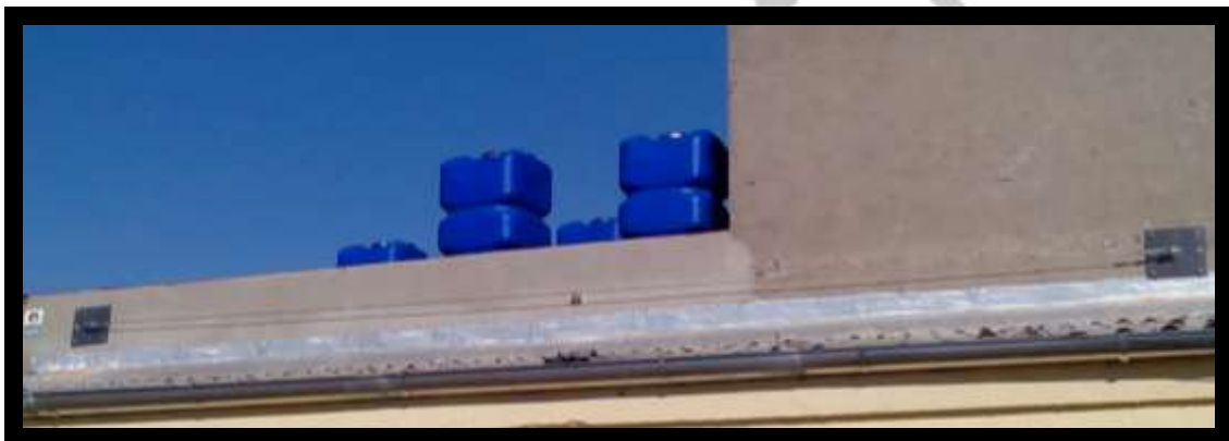
LIMPIEZA DE CANALONES
