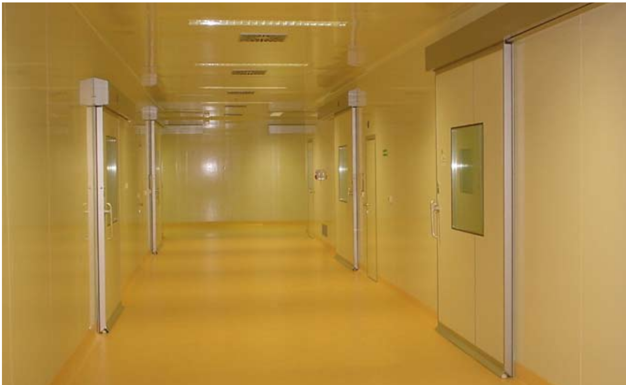
La puerta HHS-CR como cierre hacia la sala de preparación quirúrgica.
