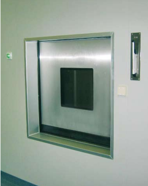
La puerta HVS-CR como cierre hermético de un montacargas.
