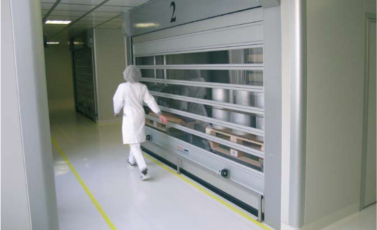
La puerta STT-CR en una esclusa de material.
