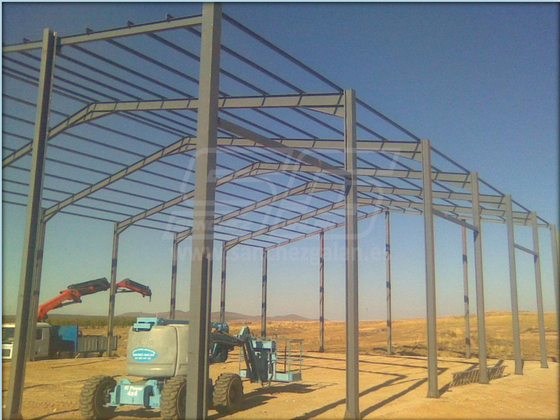
Estructuras metálicas Sánchez Galán
