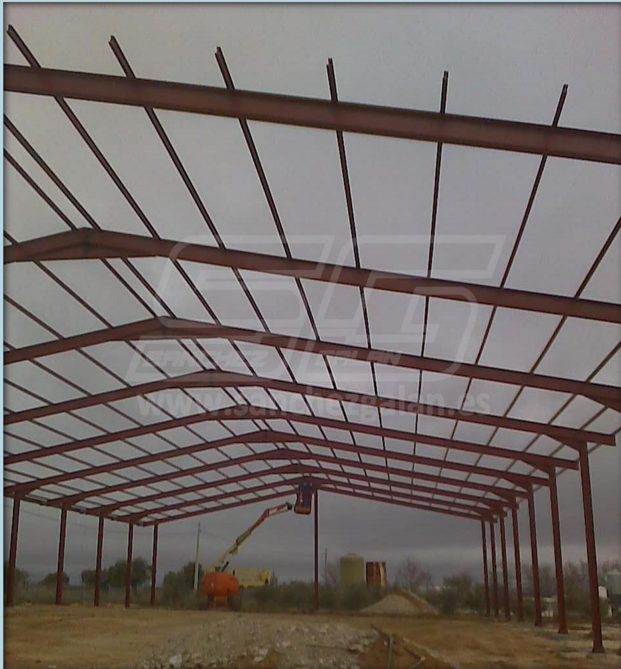
Estructuras metálicas Sánchez Galán
