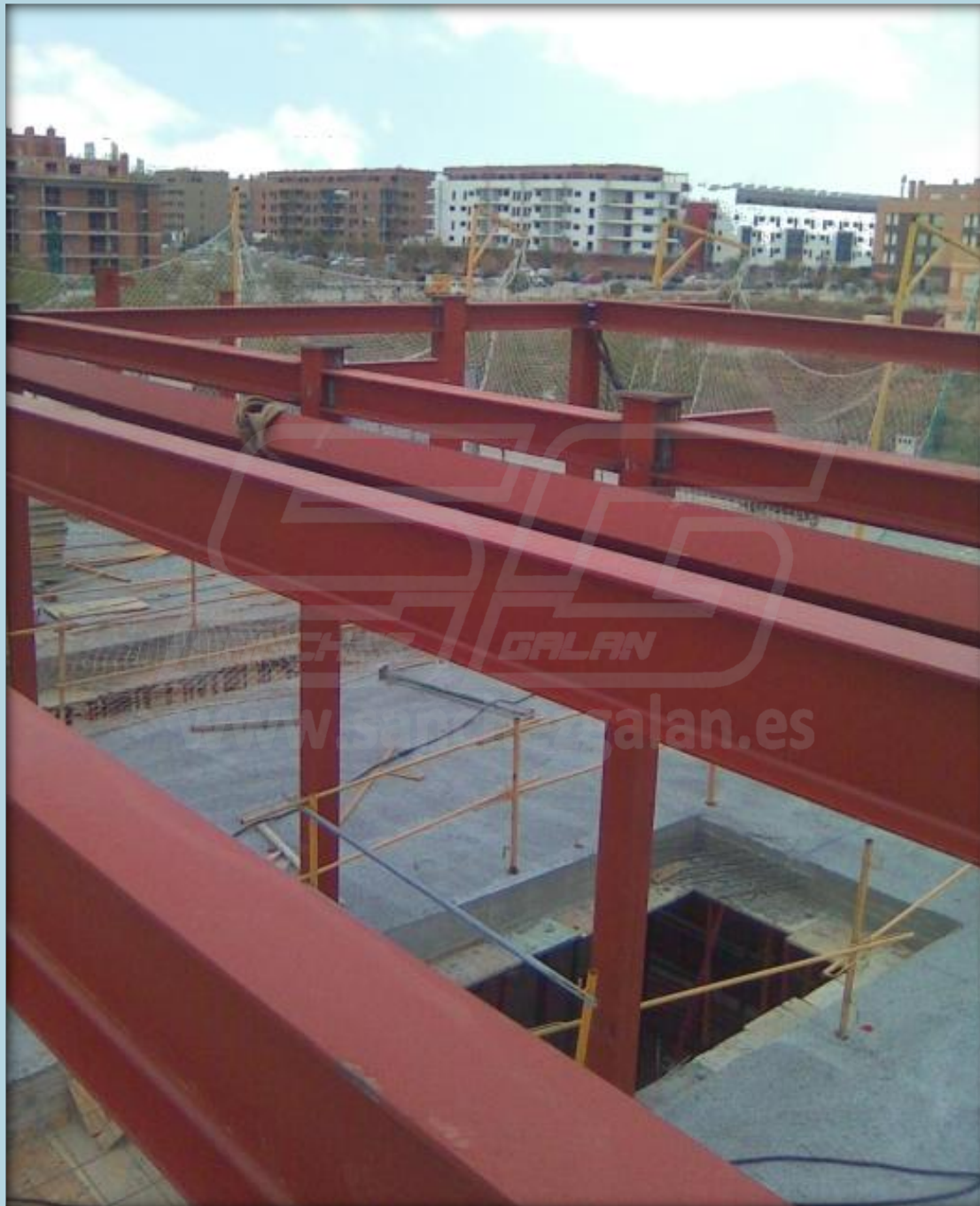
Estructuras metálicas Sánchez Galán
