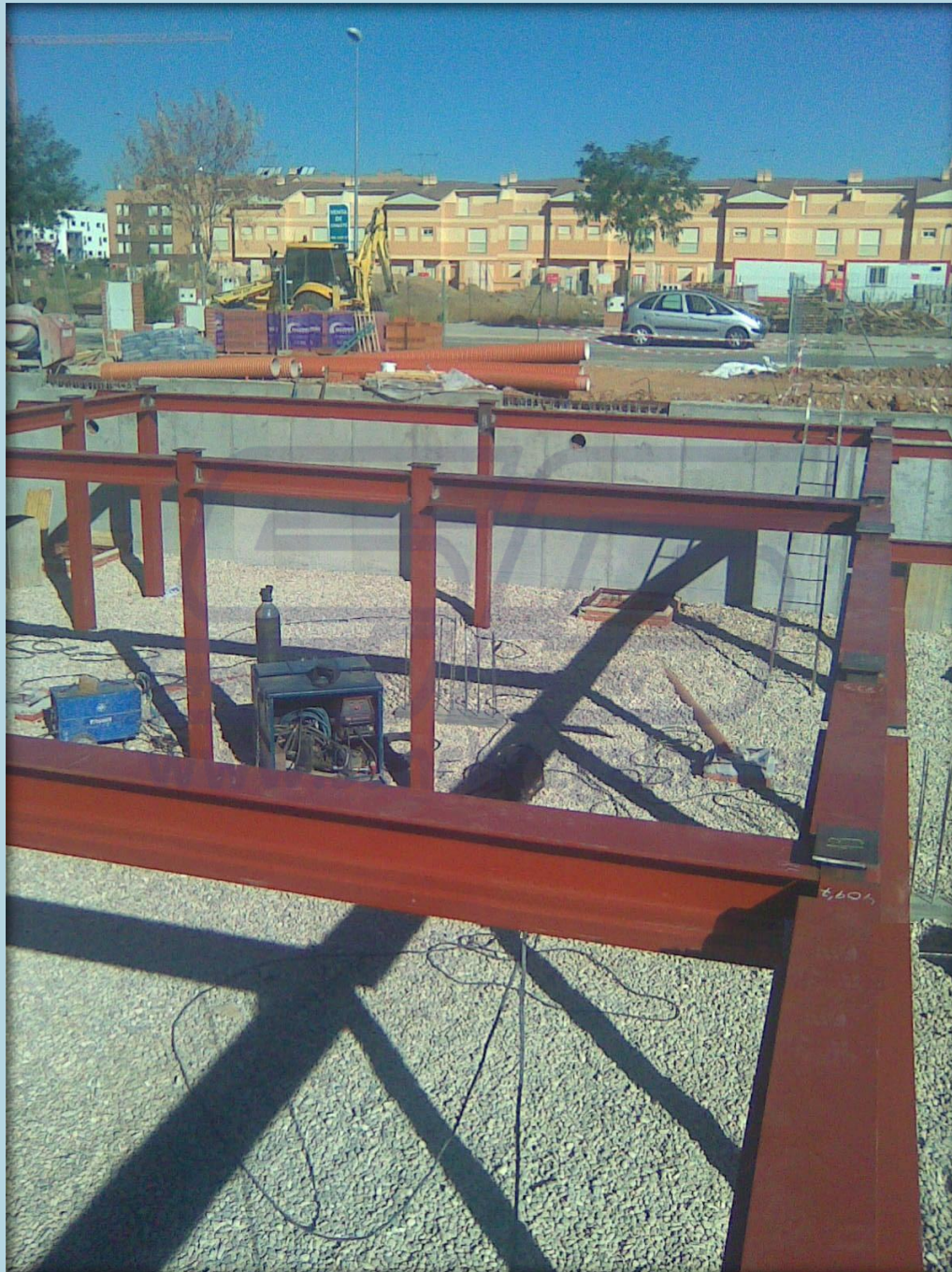
Estructuras metálicas Sánchez Galán
