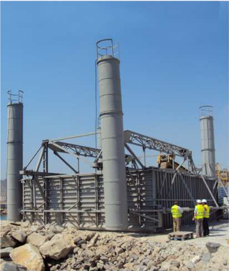
ALMERIA. ENCOFRADO HORMIGON SUMERGIDO, 2010.
