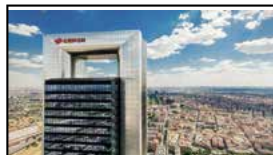
Torre CEPSA Paseo de la Castellana
