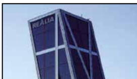
Torre Realia Paseo Castellana 216
